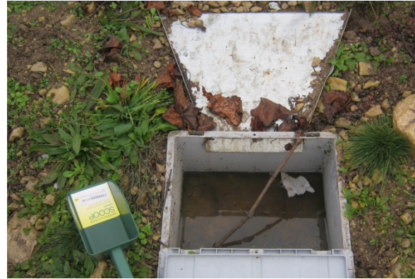
Abbildung 5: Reinigung und Kontrolle; Entnahme des Sediments am Boden der Fangbox
